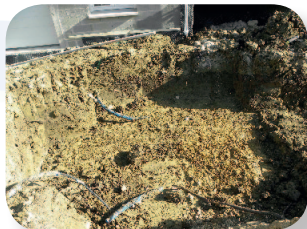
préparation du terrain
