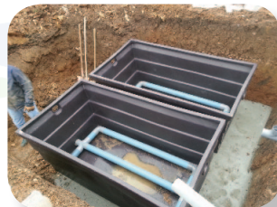
pose des drains de collecte
