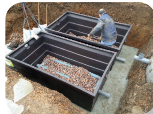
mise en place du gravier 20/40
