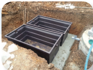
pose des bacs étanches
