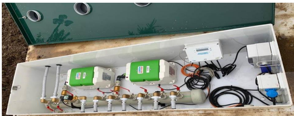
ci-dessous : centrale de commande et régulation intégrée
